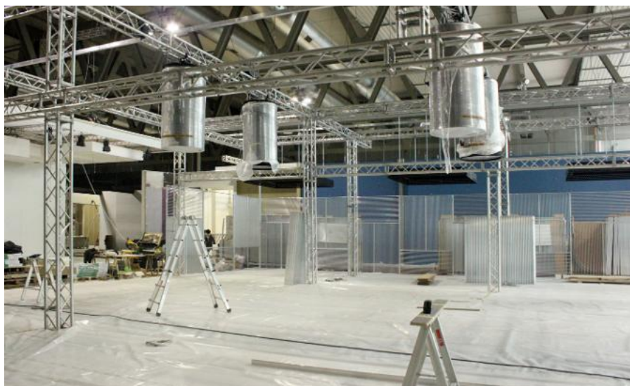
Fig. 24. Construction site photo - Estel Booth - Salone del Mobile 2012 - Milan. Photo: Filippo Romano
