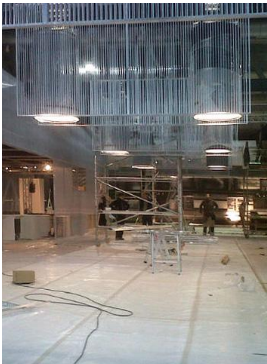
Fig. 23. Construction site photo - Estel Booth - Salone del Mobile 2012 - Milan. Photo: Filippo Romano
