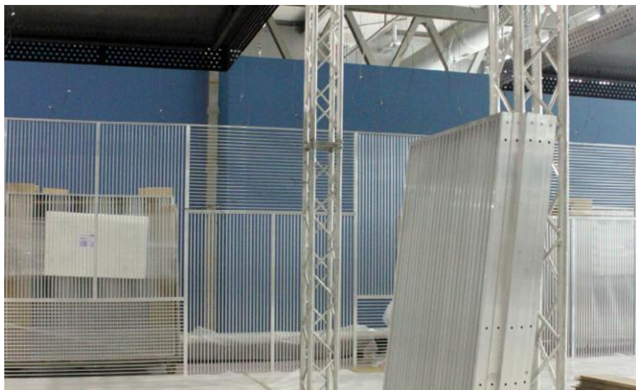
Fig. 25. Construction site photo - Estel Booth - Salone del Mobile 2012 - Milan. Photo: Filippo Romano
